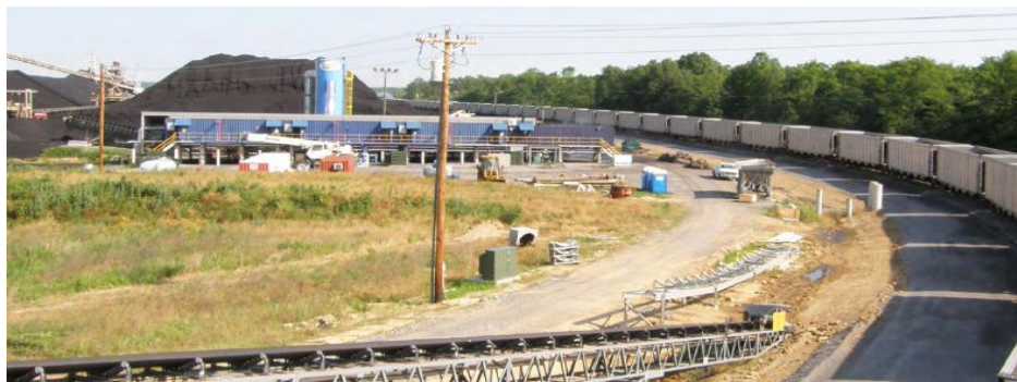
Рис. 17 – Завод СВЧ-сушки угля (вид с пешеходного мостика), г. Кавер-Сити
