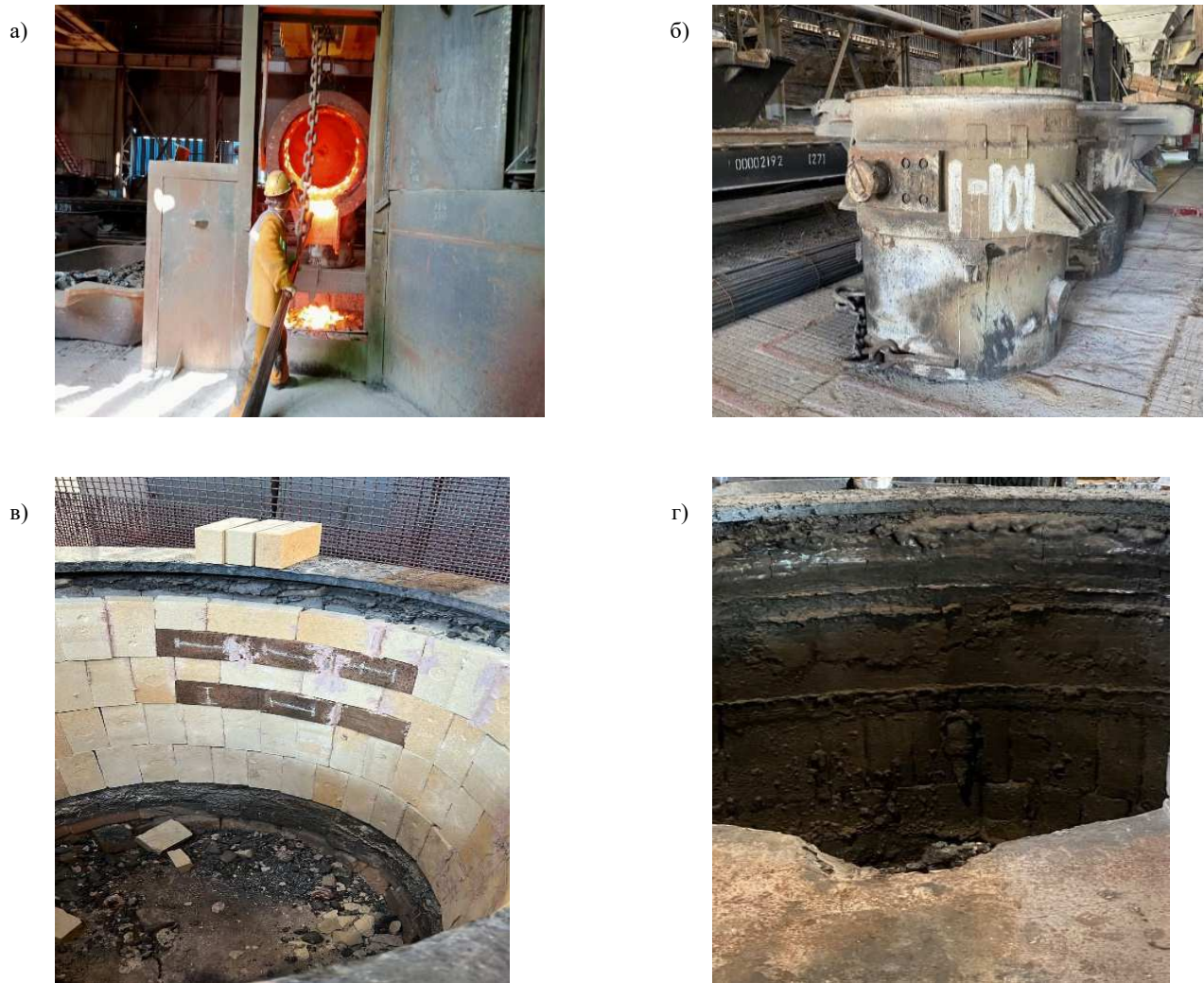
Рис. 3. Плавильный цех (ПЦ-1): а) разливка расплава из печи; б) общий вид разливочного ковша; в) общий вид внутренней кладки ковша из шамота с установленными углеродсодержащими огнеупорами состава 1 (темного цвета); г) общий вид футеровки ковша после пятикратной кампании проведения испытаний огнеупоров.
