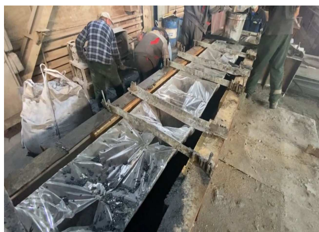
Рис. 3. Заливка приемного желоба анодной печи (Усть-Каменогорский металлургический комплекс ТОО «Казцинк»)
