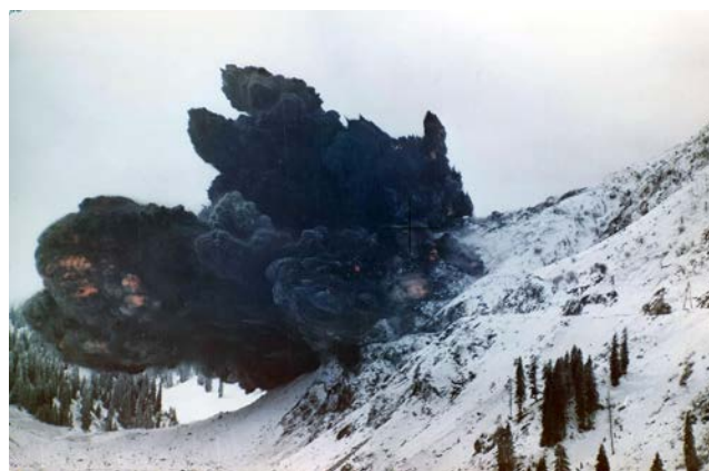
Рис. 1. Мгновенные кадры направленного взрыва при создании селезащитной плотины Медео. Фотосъемка Института физики Земли (в сторону Алматы), снимки подарены Институту гидродинамики (хранятся в Электронном Архиве ИГиЛ СО РАН).
